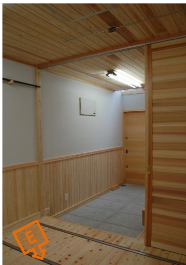
土間との間には可動式の建具が納められました。
