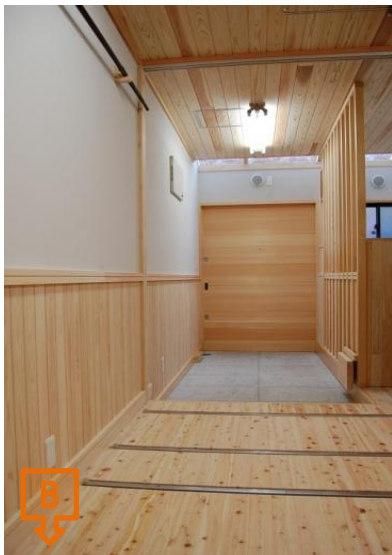
玄関引き戸は内部から見ると木製です。
